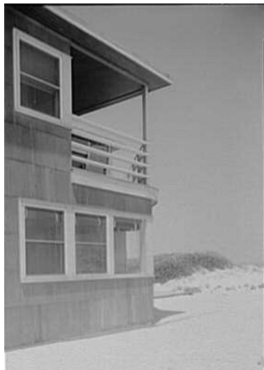
La terrasse, vue de l'extérieur.
